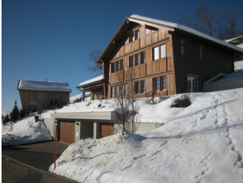
Bestehende Baute zweigeschossig
