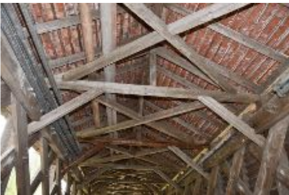
Detail der Dachkonstruktion
