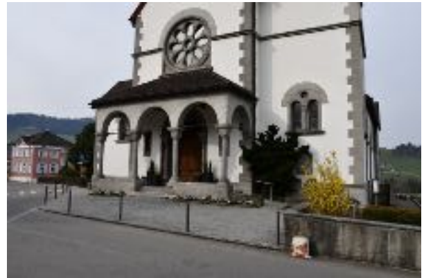
Detail mit Vorhalle.
