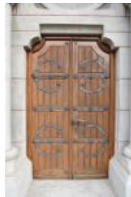
Detail mit Haupteingang.
