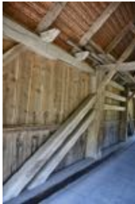
Detail Hängewerkskonstruktion
