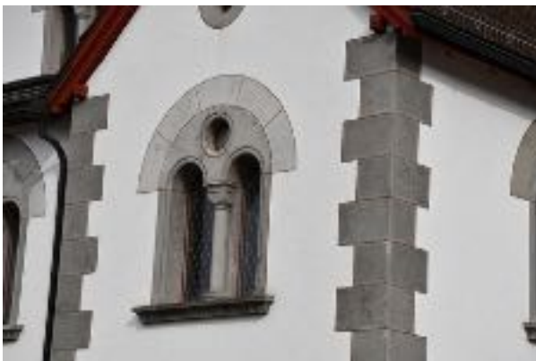
Detail von Fenstergewände.
