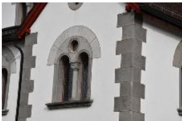
Detail von Fenstergewände.
