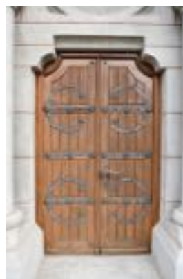
Detail mit Haupteingang.
