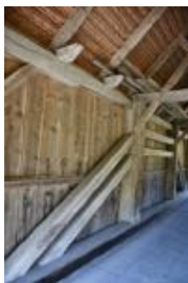
Detail Hängewerkskonstruktion
