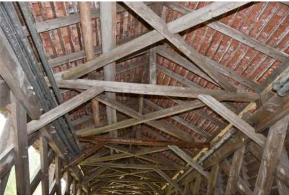
Detail der Dachkonstruktion
